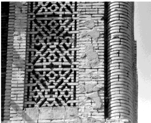
Рисунок 6. Мавзолей султана Санджара. Фрагменты штукатурки в верхнем северном углу восточного фасада (фото из архива Международного Мервского проекта, 1997 г.).
